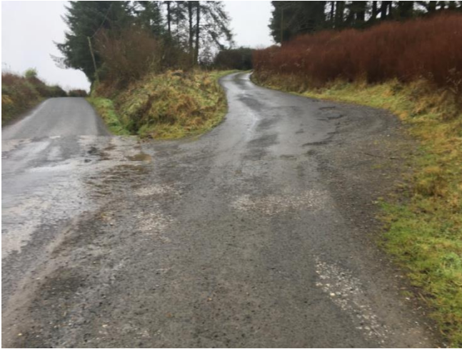
UWF Grid Connection W43 & W44
